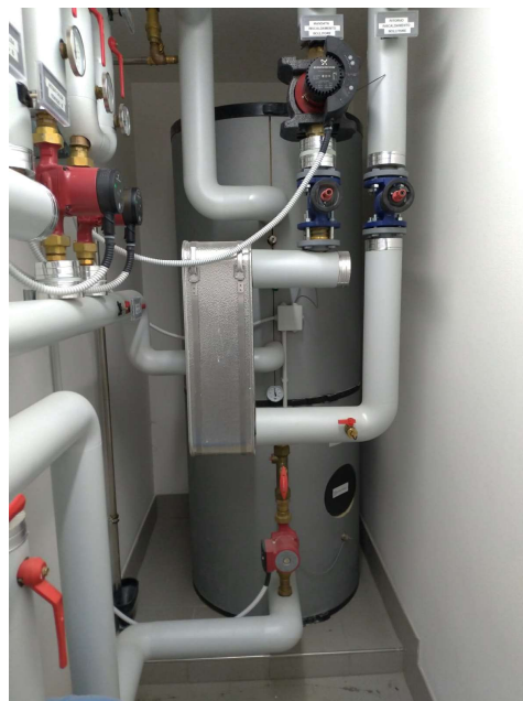
Fig. 4 – serbatoio di accumulo acqua calda sanitaria con scambiatore esterno
